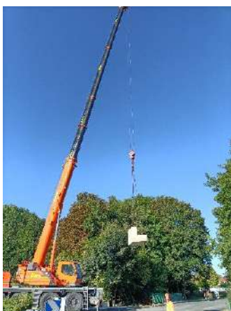
16 septembre Pose des culées, support des passerelles
