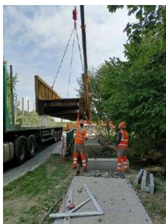
16 septembre Les passerelles prennent place
