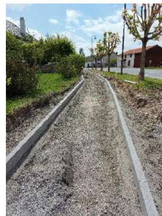
21 mai Début de la pose des bordures
