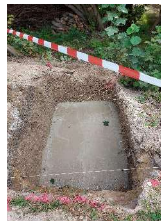
31 août Les fondations pour les passerelles
