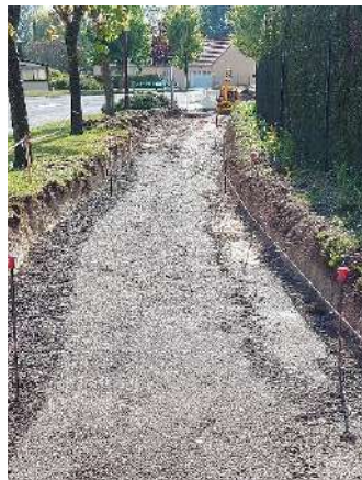
20 mai Le fond de forme est mis en place
