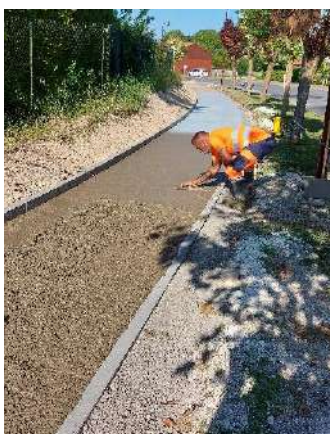
11 juin Le béton désactivé est coulé
