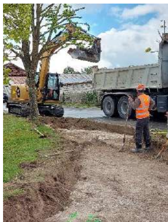
17 mai Lancement des travaux de terrassement
