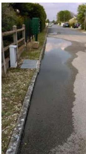
En effet, même si la bande de roulement a déjà été reprise depuis sa construction en 1988, des affaissements importants réapparaissent, créant ainsi des flaques d'eau dangereuses pour la circulation.
